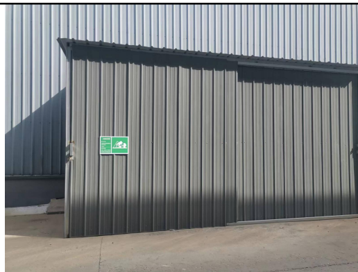
一般固废暂存处
