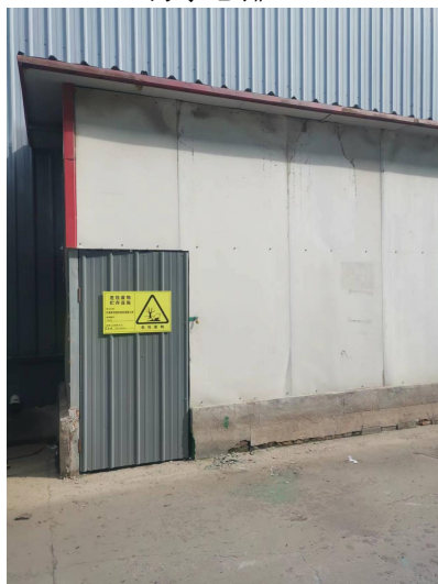
危废暂存间外部
